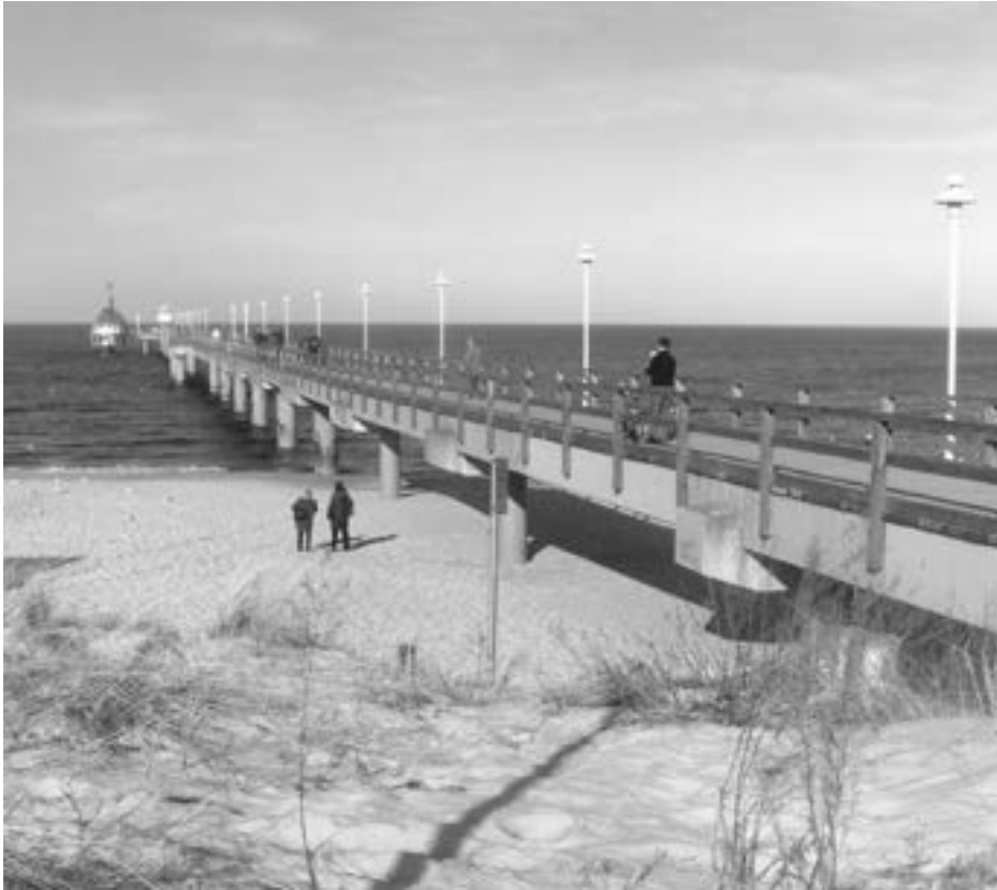
Seebrücke Zinnowitz mit begehbaren Tauchglocke
